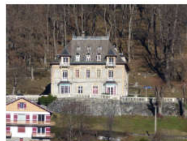
Fig. 3 - Villa, façade sud-ouest. Auteur : Comet, Anaïs
