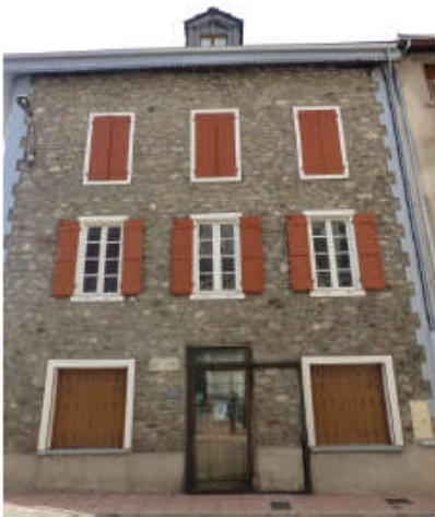
Décroustage de façade photo Anaïs COMET inventaire 2018 villa Beurivage. Une analyse portant sur l'art de bâtir et sur les performances énergétiques devrait conduire à d'autres choix plus pertinents au regard de l'édifice et de sa qualité patrimoniale.
