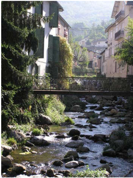
La Lauze, ses passerelles et les façades qui la bordent.
