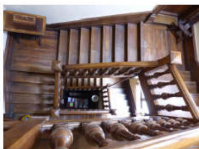
Fig. 16 - Escalier, vue zénithale. Auteur : Comet, Anaïs
